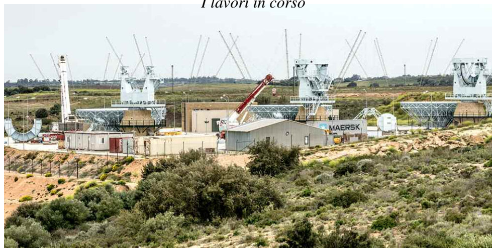
I lavori in corso
