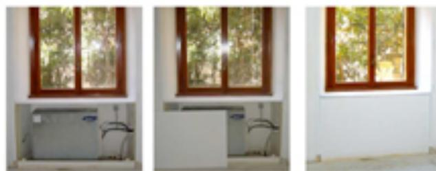
La linea **Elfo** fornisce i vantaggi dei classici sistemi **"bi-split"** uniti alla flessibilità di installazione di un normale climatizzatore split, il risultato è che l'unità interna può essere posizionata in sala o in camera da letto mentre la motocondensante è installata in cantina, in soffitta o in ogni luogo all'esterno della casa.
