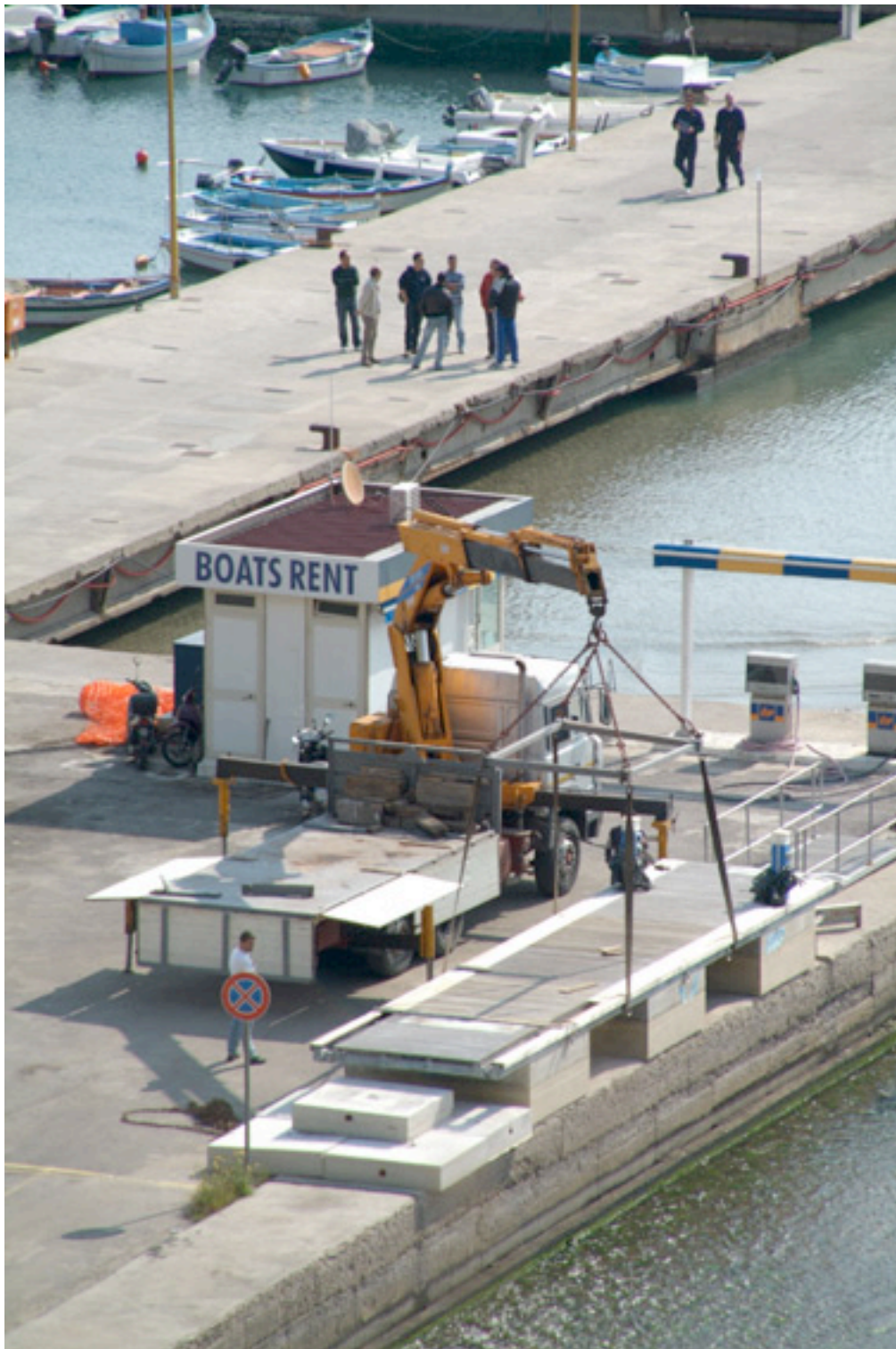
- 2 maggio, mattino, il "tre assi" inizia le operazioni di carico di un "pontile galleggiante"
